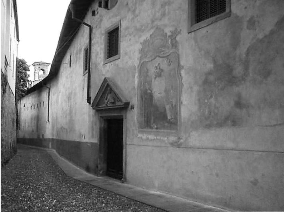
Il monastero di S. Grata visto da via Arena.
