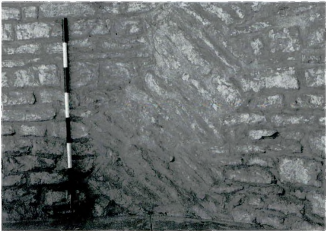
ex-Via degli Anditi: particolari della tecnica costruttiva; il tratto di muratura "obliqua".
