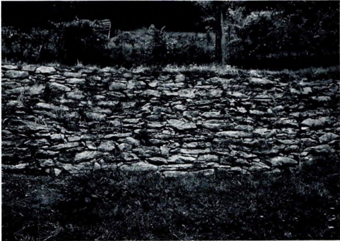
8. Parte alta della Mora (mapp. 87): alta muratura a secco, con notevole riporto di suolo agrario; ottenuta con pietrame gróssolano e poco lavorato, evidenza piú di una fase costruttiva.
