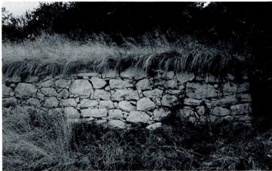
9. La Sela (mapp. 410): muratura a secco posteriore al 1853, realizzata in un'unica fase costruttiva e con particolare cura; il pietrame, di pezzatura tendenzialmente uniforme, risulta in parte lavorato e commesso con l'uso di abbondanti zeppe.
