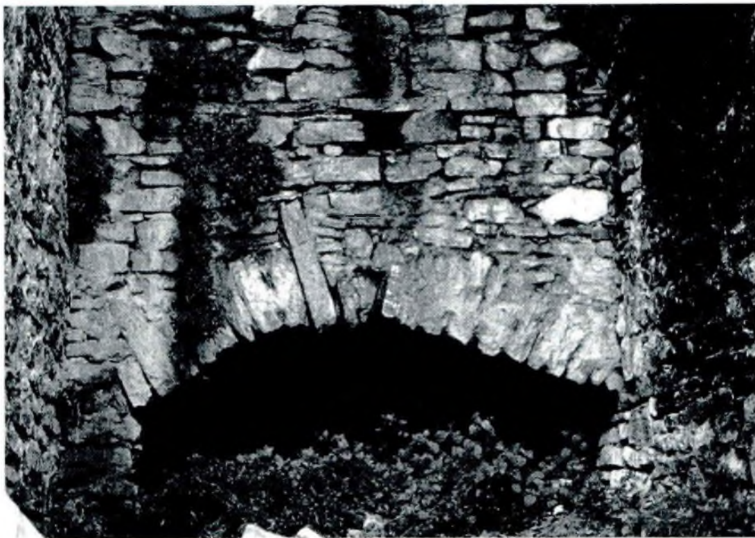
Monastero di S. Grata: particolari della tecnica costruttiva degli arconi.
