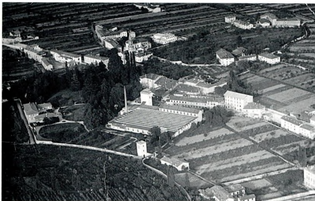
4 – Stabilimento Reich, già Zuppinger, a Torre Boldone; primo Novecento.
