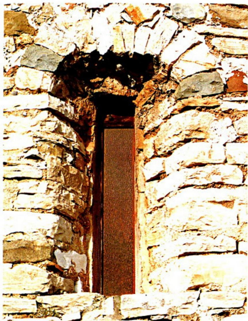
*Particolare della monofora meridionale dell'abside (la forma dell'arco appare molto schiacciata perchè i pezzi centrali sono stati sostituiti in occasione dei lavori del 1973).*
