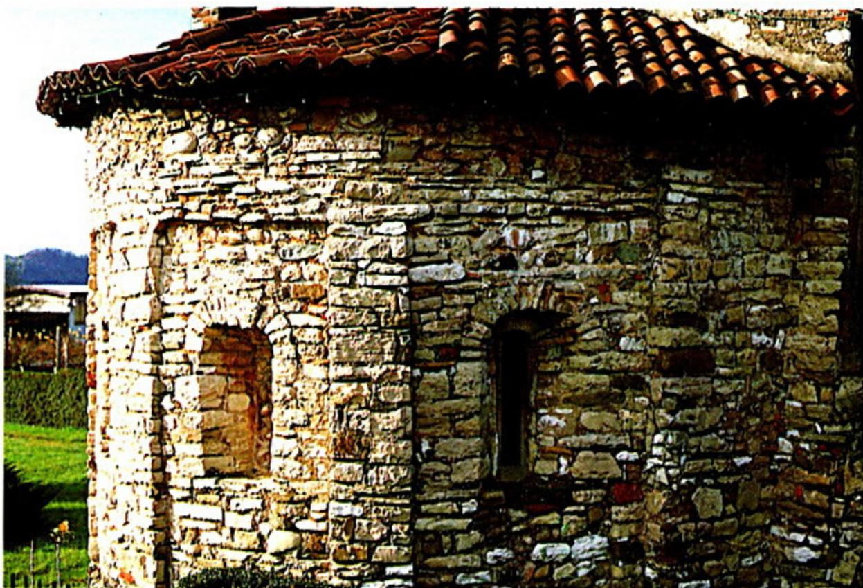
*La metà settentrionale dell'abside, ove si notano il rifacimento della sommità della specchiatura di sinistra e la parziale ricostruzione della specchiatura di destra e della monofora in essa compresa.*
