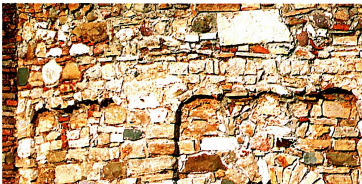
*Particolare dell'abside, con il sovrizzo realizzato con materiali disomogenei e pezzi di recupero, e la traccia degli archetti asportati in vista dell'intonacatura (fase 6).*
